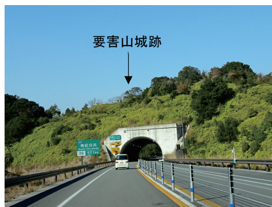
写真 3-3 遺構の保存のためトンネル工法へと変更された箇所(紀勢自動車道紀勢線)
