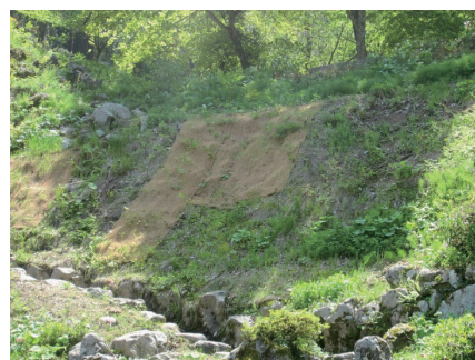
写真 10-2 景観に配慮した斜面保護の例 (一乗谷朝倉氏遺跡)
