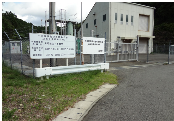
(樺地区にある白浜町最終処分場)
