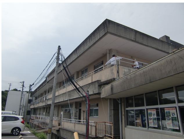
(老朽化著しい現庁舎裏手側)
