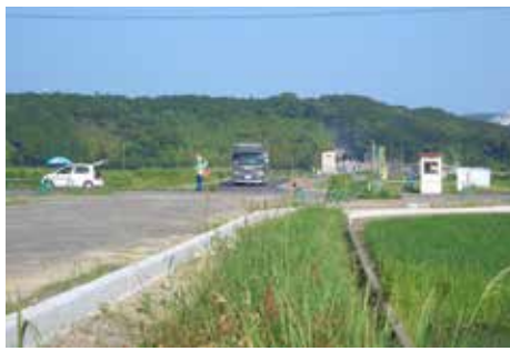
(フラワーライン線中地区観音道の交差点付近)
