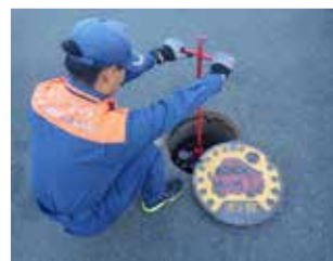
消火栓の点検の様子
