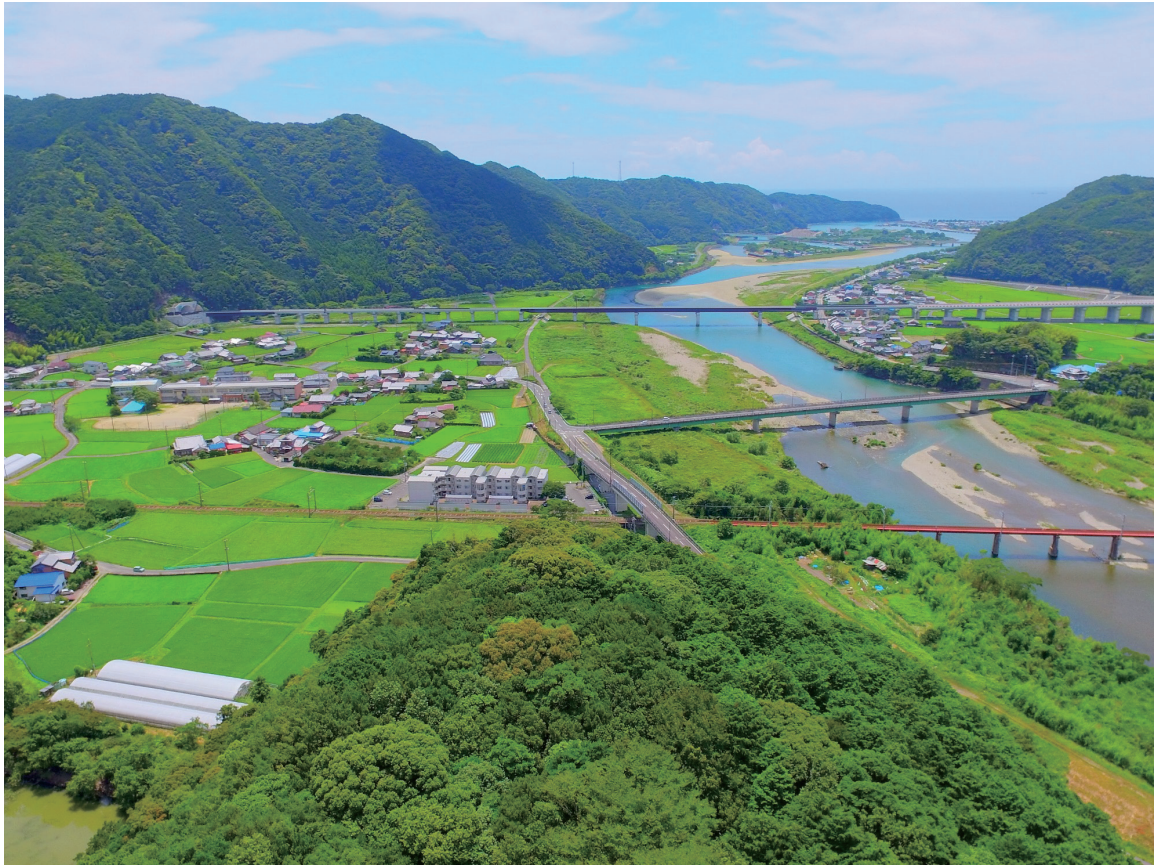
八幡山城跡上空から日置川河口を望む
