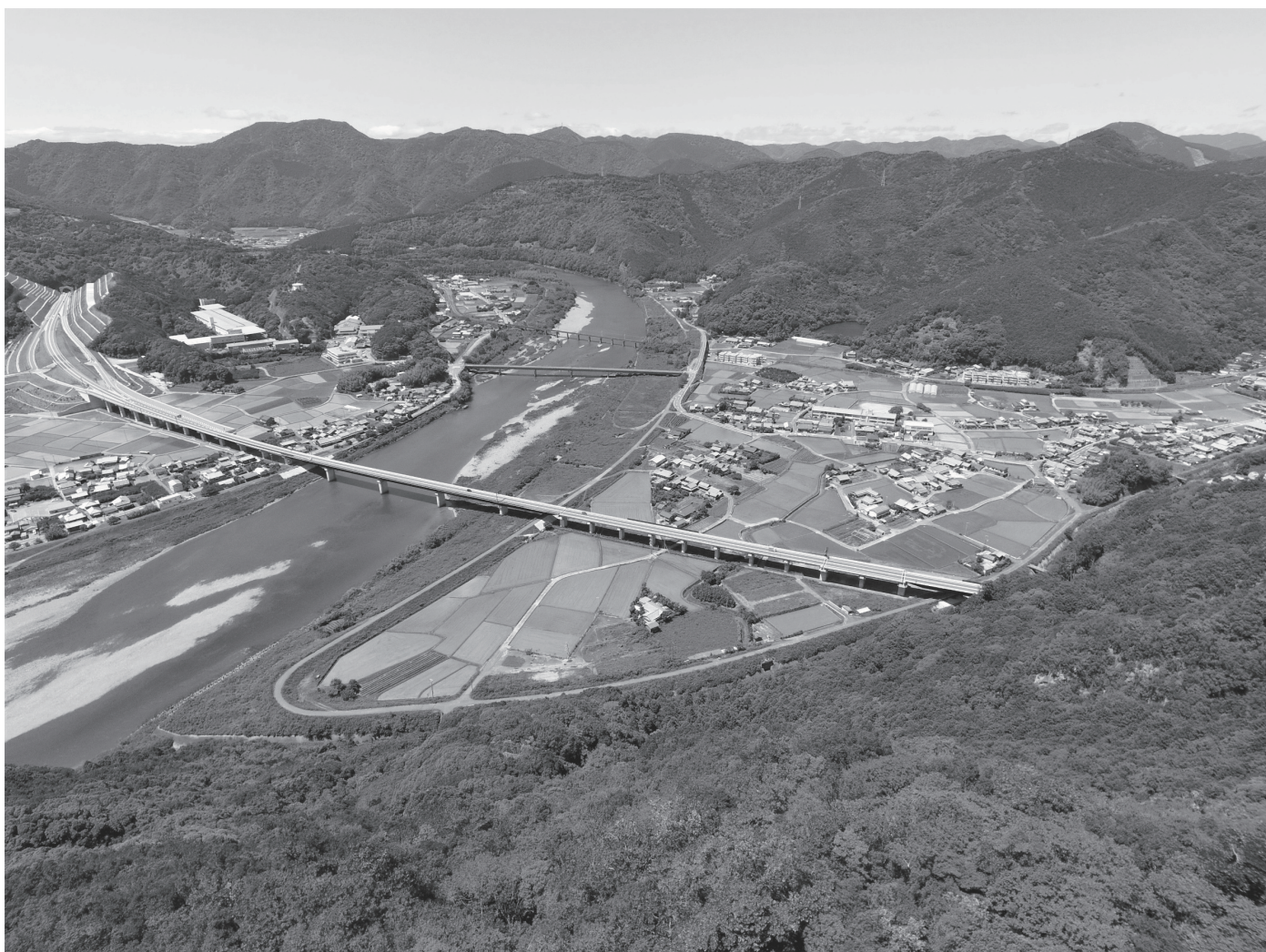
勝山城跡上空から安宅氏城館跡・日置川を望む
