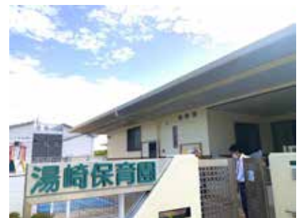
( 現地調査：湯崎保育園建設事業 )
