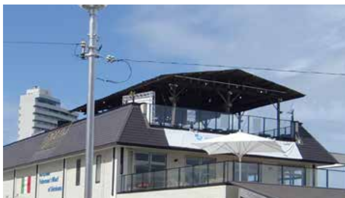
(フィッシャーマンズワーフ白浜屋上の木造構造物、現在は是正されている)
