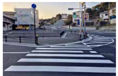
交差点改良工事で役場下に信号機が付きました
