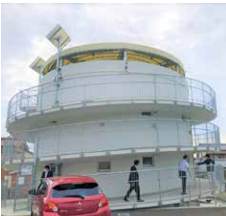
（現地調査：日置地区津波避難タワー）
