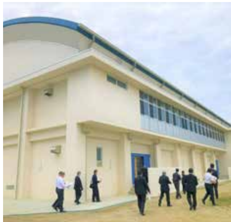
（現地調査：富田中学校屋内運動場）
