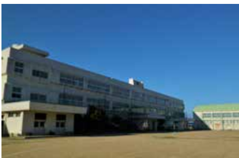
(洋式トイレの設置が望まれる町内小中学校)
