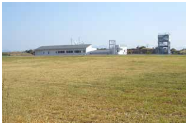
(旧白浜空港の滑走路)
