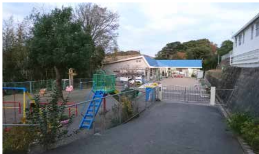
(老朽化と耐震未整備の湯崎保育園)
