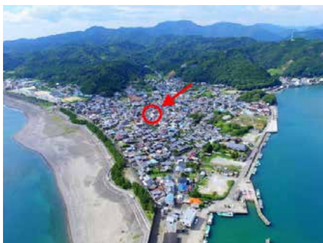
(避難ビル建設の提案場所“日置区浜町”)
