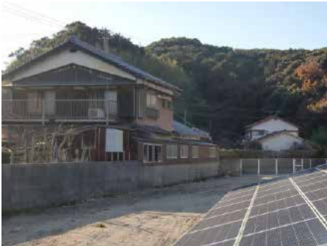
(住宅街に設置された太陽光発電)
