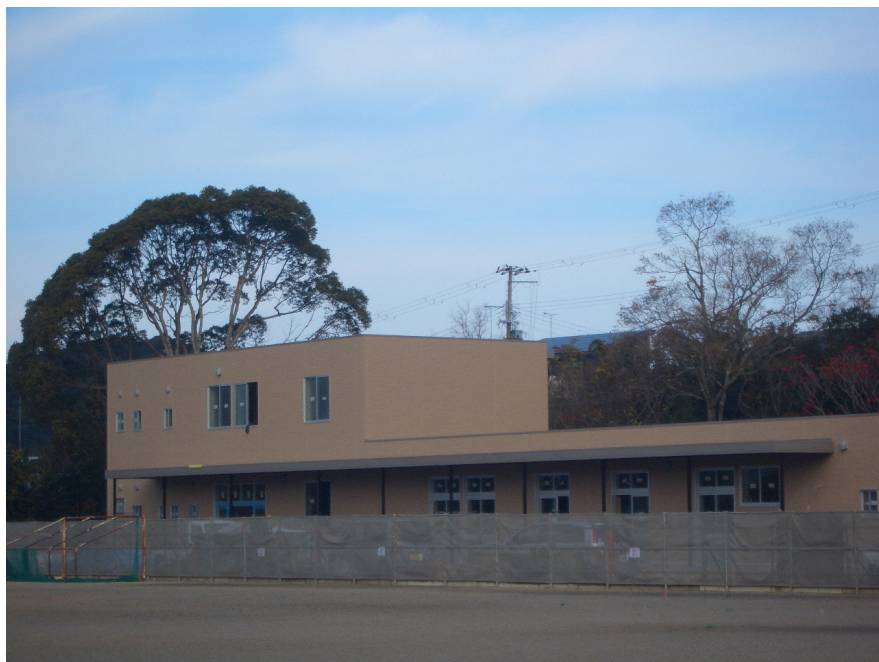
(建設中の西富田学童保育所「第二」)
