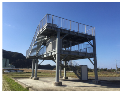
(富田地域の津波避難タワー)
