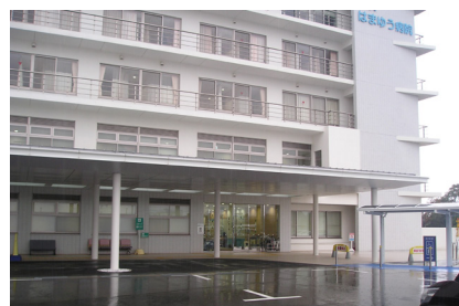
(災害時の配水が懸念される 白浜はまゆう病院)
