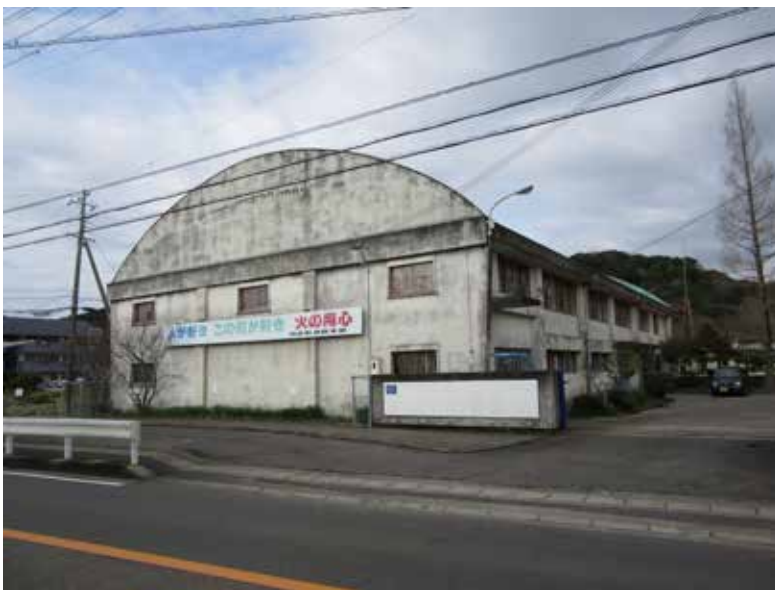
(老朽化が進んでいる富田中学校体育館)
