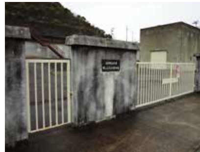
(オレンジランド配水場)
