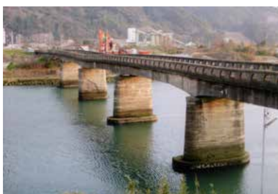
(現在通行止めの旧日置大橋)
