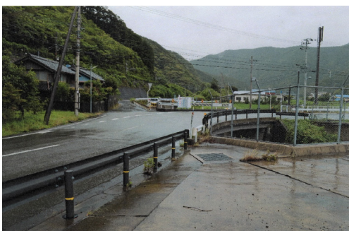
(県道・日置川大塔線、田野井長瀬の平常時)
