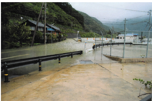
(県道・日置川大塔線、田野井長瀬の冠水時)
