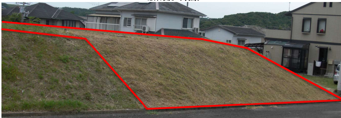
北東側より撮影
