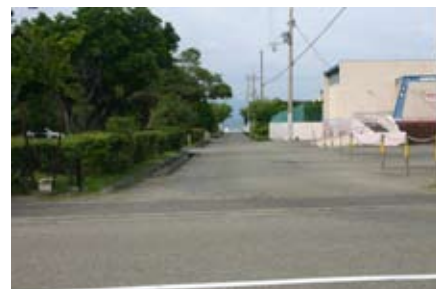
【白浜会館と町民プールの間の道路を舗装します】
